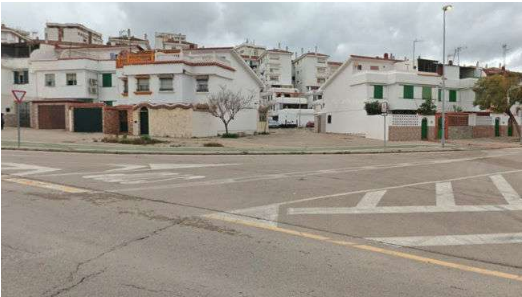
Una avería de una boca de incendios deja sin agua a algunas calles del Saladillo
