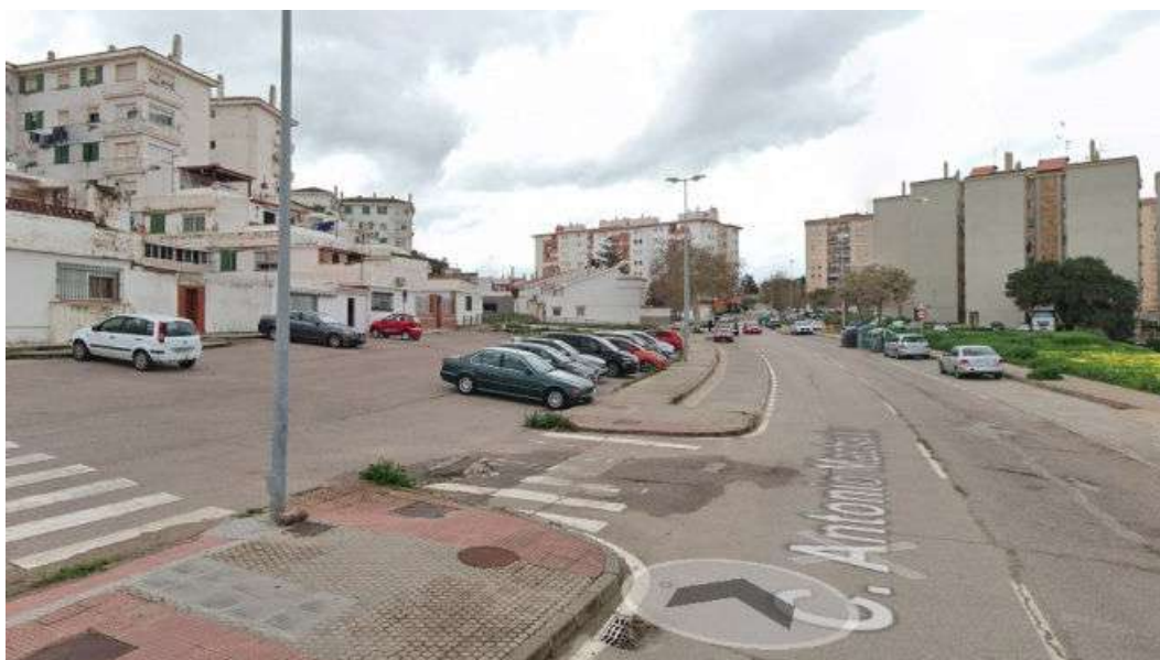
Emalgesa repara la avería en un hidrante de la calle Antonio Machado en Algeciras
