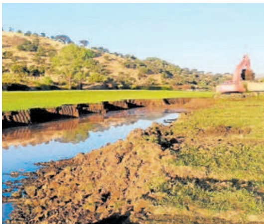
Limpieza de lodos en el embalse de Valencia del Ventoso. hoy
