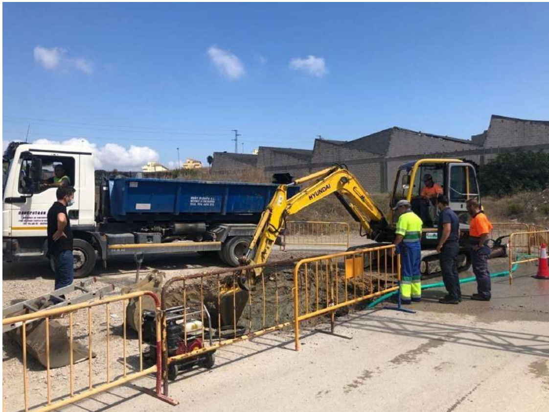
Imagen de archivo de una reparación de Emalgesa.
